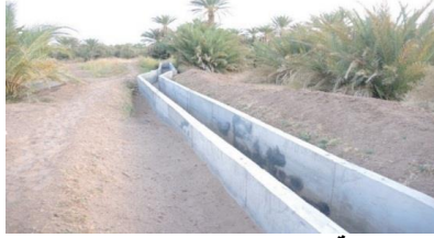
صورة رقم 6: تقنية تبليط السواقي الترابية لتدبير المياه والحد من زحف الرمال، معاينة ميدانية، ماي 2019
