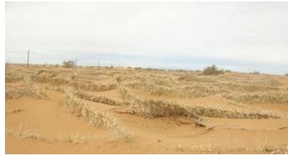
صورة رقم 7: تقنية التثبيت الميكانيكي للتقليل من زحف الرمال، معاينة ميدانية، غشت 2019
