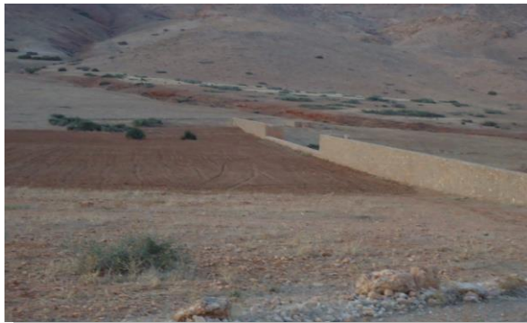
الصورة 2: السد التلي تنزي يستغل في الزراعة بعد توحد كلي
