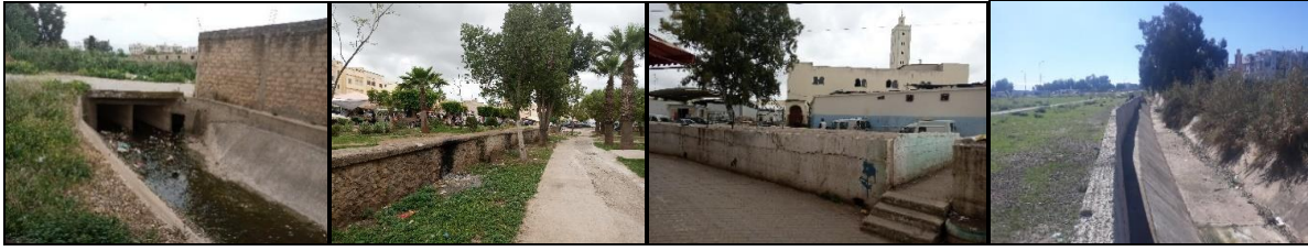
Photos de quelques ouvrages de protection sur Oued El Mehrz au niveau du quartier Montfleuri prises le 14/04/2021.
