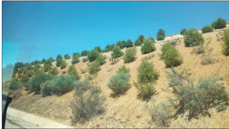
الصورة رقم 7: الحماية بواسطة التشجير، الطريق السياح وجدة فاس (إقليم تازة، 28-03-2017)
