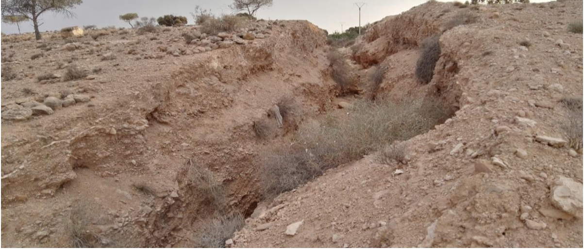
الصورة رقم 9: نحت وتآكل بفعل التعرية المائية.
