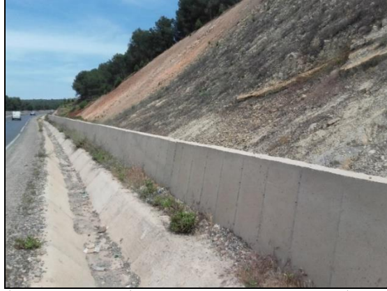
الصورة رقم 8: الحماية بواسطة الحواجز، الطريق الوطنية رقم 2 (منطقة الكربوز، 11-04-2017)
